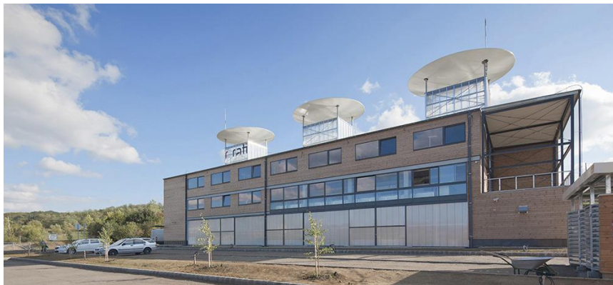
22. ábra: : A kivitelezett ipari és irodaépület északi fő homlokzata
