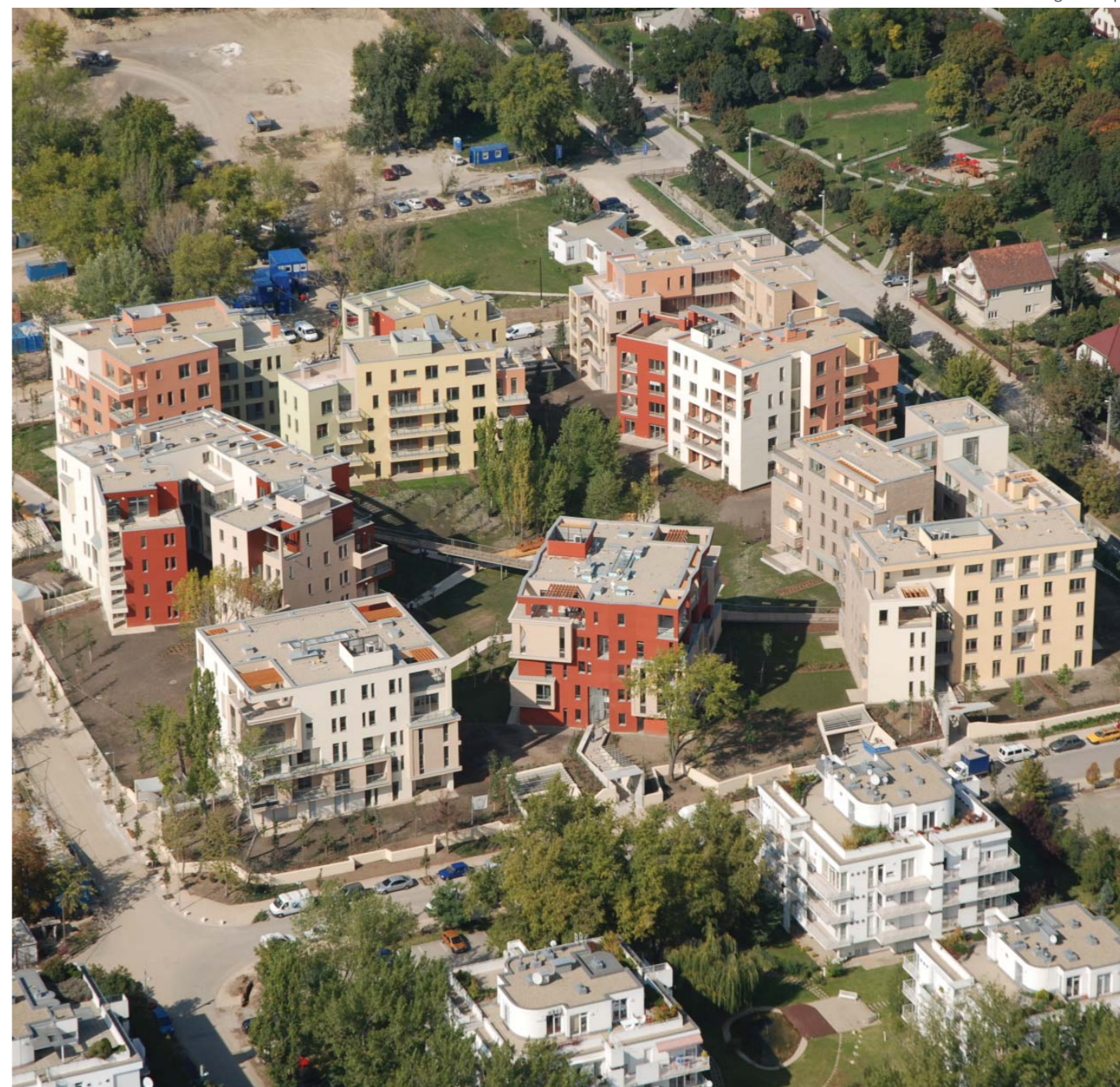
Sasad Liget lakópark, légifelvétel az épülő T1 tömbről
