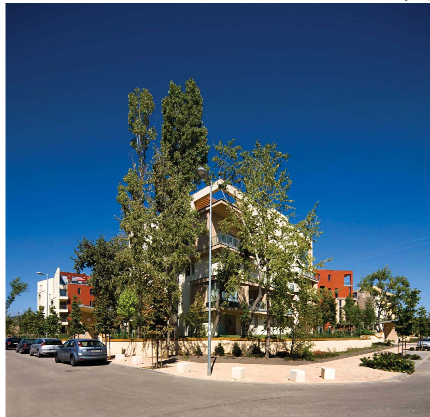
T1 tömb beépítés, helyszíni foto
