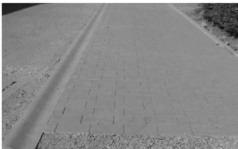
2012.08.15. Széchenyi I. utca kerékpár út építés
