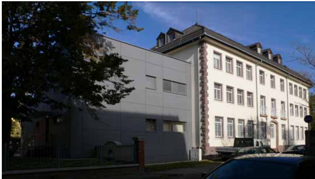
Déli homlokzat fotó: Sz.E.
