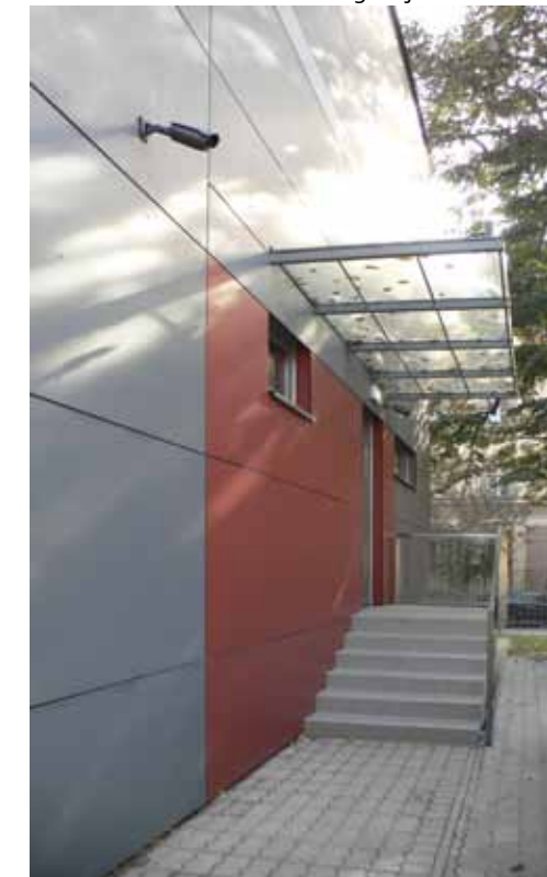
Gazdasági bejárat fotó: Sz.E.
