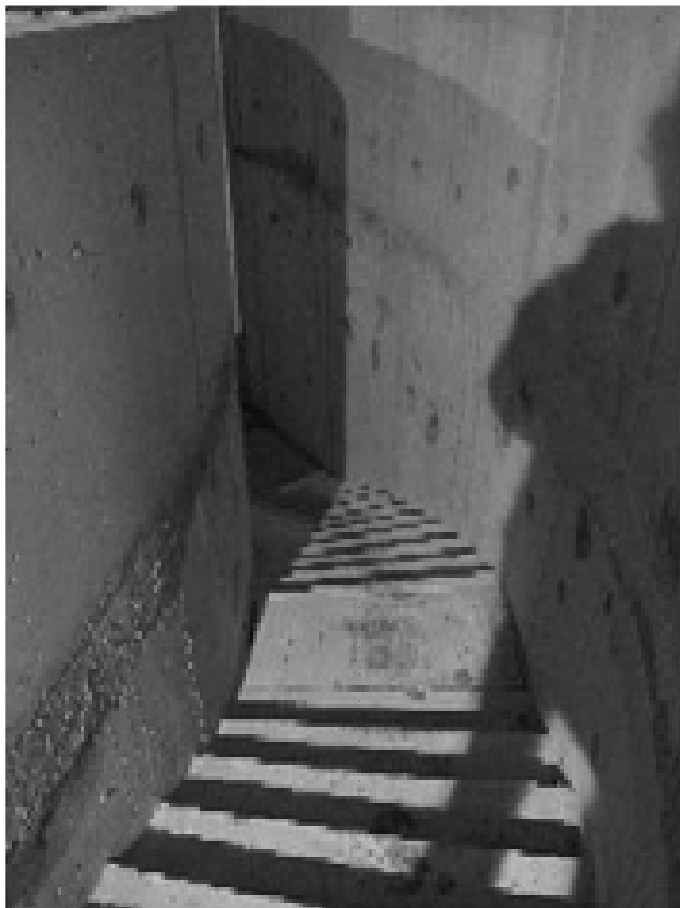
a lépcsőkar szerkezetkész állapota
