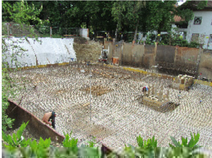
az alaplemez vasszerelése
