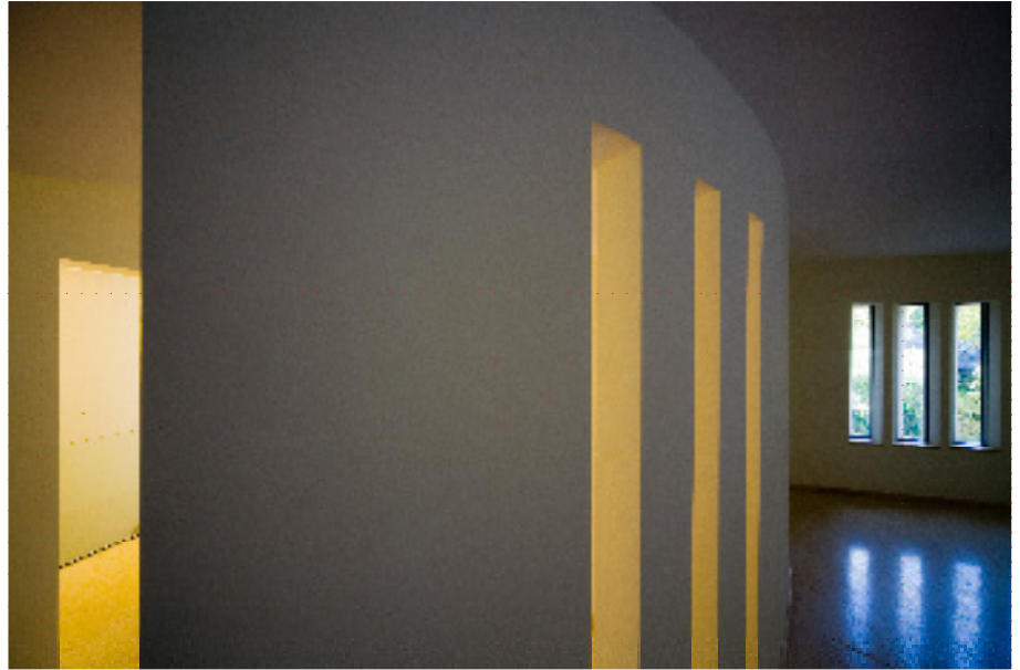
az utcai homlokzaton kinyúló nagy íves fal belső folytatása a második emeleti lakásban az előtér-hallt választja el a nappali-étkező tértől fotó: Zsitva Tibor, 2013
