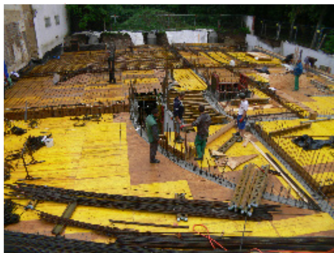
a pinceszinti vasbetonfalak
