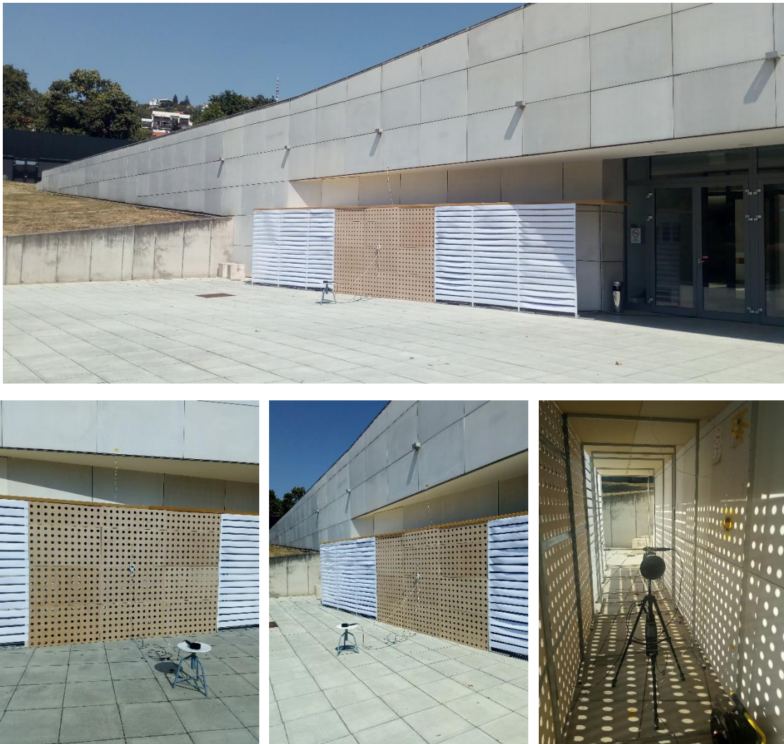
21. ábra: Fotók a mérési installációról (85%-os árnyékoltsághoz tartozó felépítmény)
