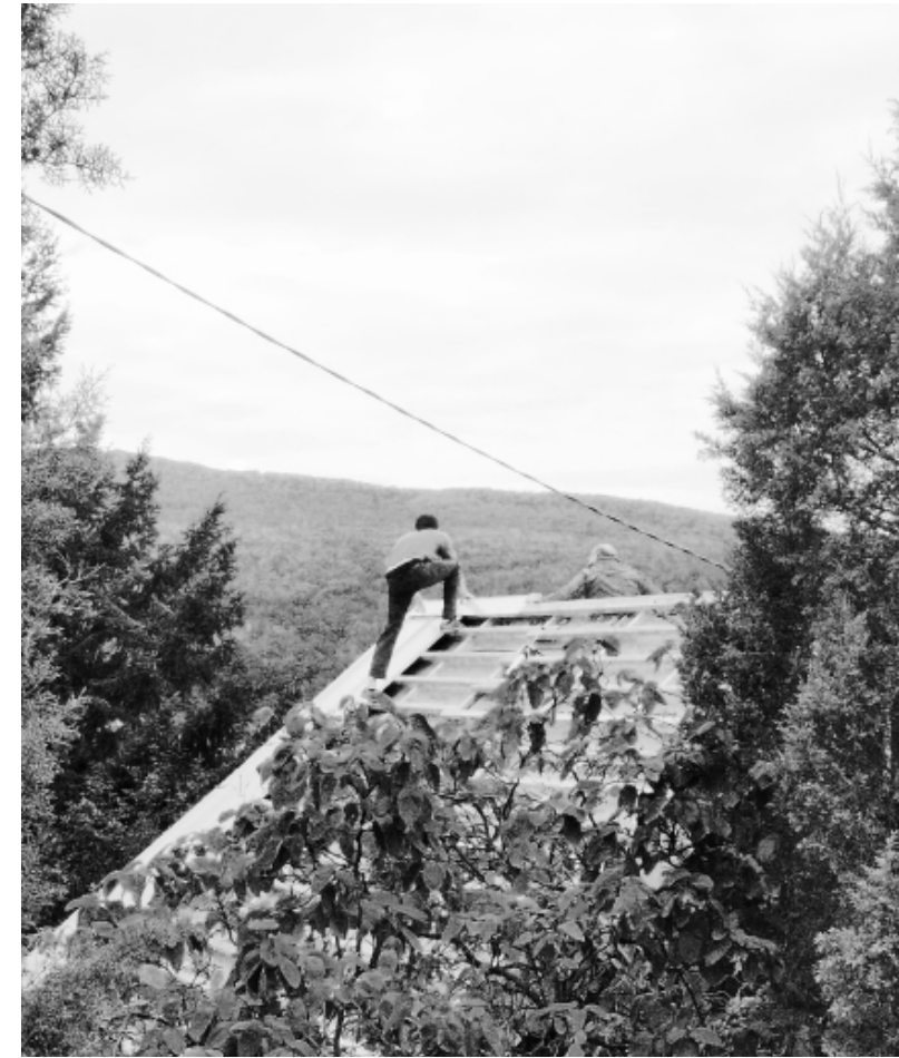
3. ábra - tetőfedés saját fotó
