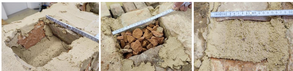
26. ábra Rejtett anomáliák az épített falban (üreg, téglatörmelék és habarcs kitöltés) [saját felvétel]
