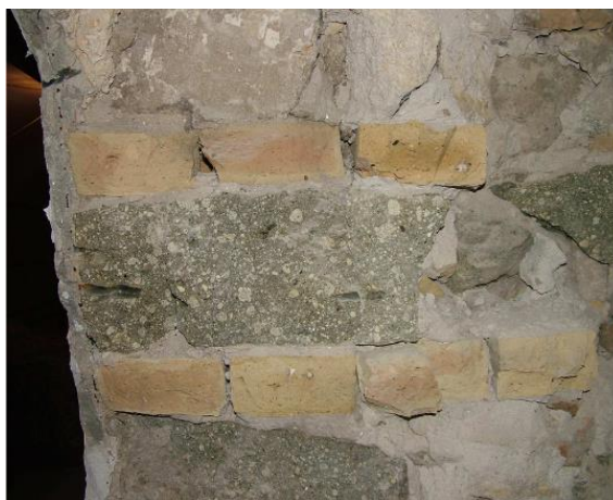
8. ábra Szabályosan váltakozó kő és téglasorból épített pincefal [10]
