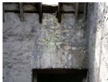
54. ábra - Sérült fedélszerkezet és repedt áthidalás, S8-S11 helyiségben
