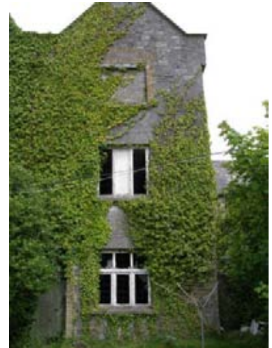
60. ábra - A repkény borította déli homlokzata a szállás épületnek, helyiség G20-F15-S10
