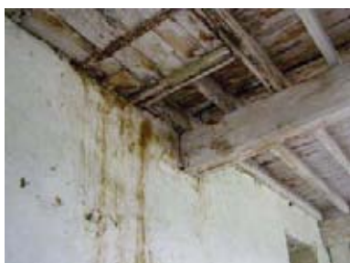
88. ábra - Beszivárgó csapadékvíz a G19-es helyiségben
