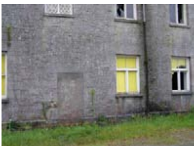
82. ábra - Befalazott nyílás és hibás csatorna a G11 és a G14 jelű helyiségek között
