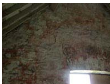
52. ábra - Kiterjedt repedések az ablak fölötti áthidalásnál, néhol 10mm szélességben, S6
