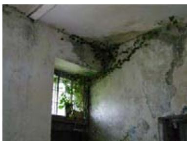
86. ábra - Kúszónövények a G20 jelű helyiség belterében, nedvesedés a födém körül
