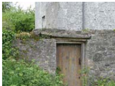
71. ábra - Y10-es jelű kertfal kapujának sérült kő áthidalója
