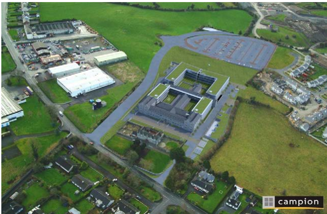
5. ábra - A tervezett bővítés, a forgalommentesítő út és a parkoló a légifelvételbe beillesztve jól mutatja a beruházás léptékét. A meglévő épületet határozottan szervezi egészé a bővítés.
