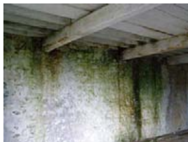
89. ábra - Víz beszivárgás a vápánál a második emeleten, F15
