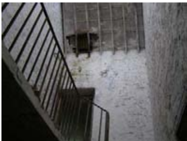
76. ábra - sérült fedés az F8 jelű lépcső felett
