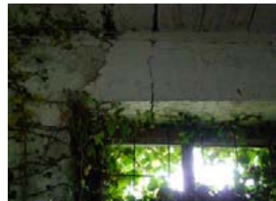
74. ábra - Megrepedt áthidalás a délkeleti sarkon, G19-es helyiség
