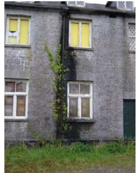
63. ábra - Hibás eres az G5-ös jelű helyiségnél
