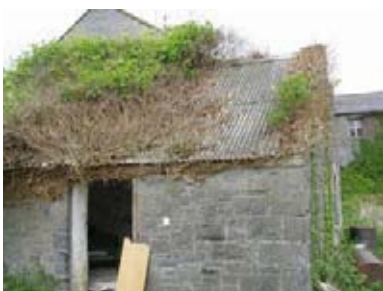
97. ábra - Növényekkel benőtt palatető, megrongálódott ereszt
