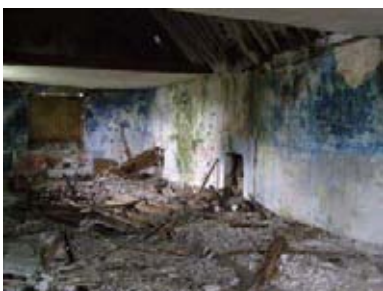
99. ábra - Leszakadt mennyezet a padlástérben, S6
