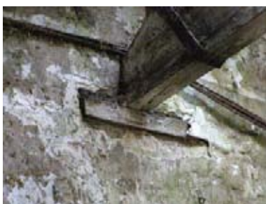
104. ábra - Rohadó gerenda és annak ideiglenes alátámasztása, G36 helyiségben
