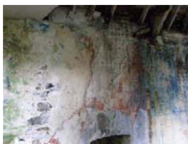
50. ábra - Leomlott mennyezetnél megjelent repedések, S6
