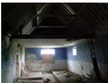
101. ábra - A megmaradt mennyezet az összeomlás határán, S6
