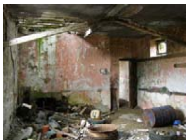
91. ábra - A G46 helyiség komoly károsodást szenvedett fafödeme
