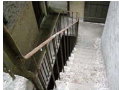
78. ábra - Tipikus konzolos kőlépcső, helyiség F8
