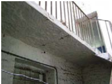
77. ábra - Tipikus konzolos pihenő, helyiség F8
