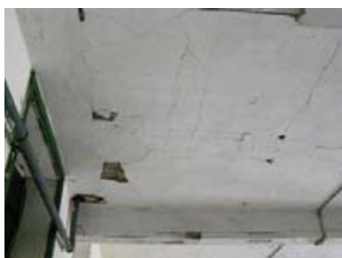
87. ábra - Sérülések és repedések a mennyezeten, G14 helyiség
