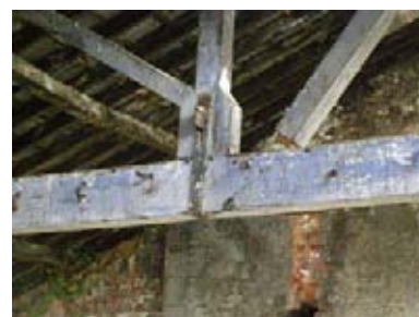
105. ábra - Sérült és hiányos fedélszerkezet a G48 helyiségben
