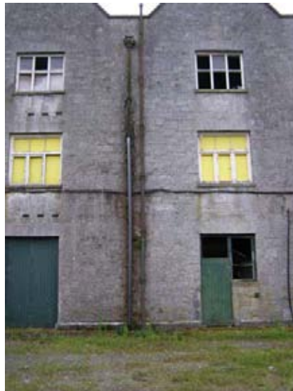
62. ábra - Eredeti és új csatorna nem funkcionál a G6 és G10 jelű helyiségek között
