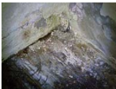
80. ábra - Nedvesség beszivárgás és gyökerek okozta károsodás, helyiség G11
