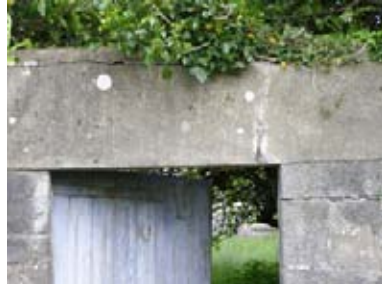
68. ábra - Y10-es jelű kertfal repedt kő áthidalója
