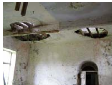
93. ábra - A G45 helyiség sérült mennyezete
