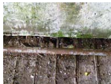
81. ábra - Sérült fapadozat, helyiség F15
