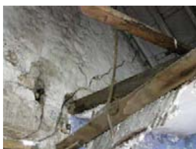
49. ábra - A néhol 15mm széles repedések borította oromfal, ablak áthidalás az S6-os helyiségben
