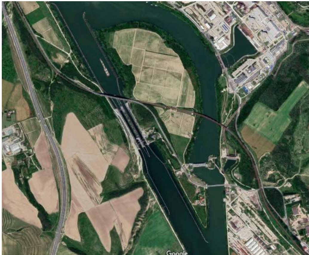
59. ábra: A Duna–Fekete-tenger-csatorna kezdeti szakasza a cernavodai atomerőműnél létesített zárógáttal és hajószilippel Forrás: Google maps
