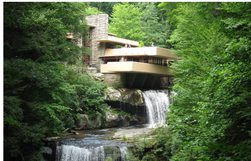
▲ 14.09 Vizesés-ház (Fallingwater), Mill Run, PA, USA, 1939. | Frank Lloyd Wright
