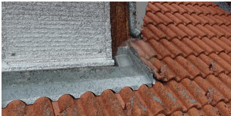
17. ábra A videóból exportált képek alapján előállított pontfelhő részlet a felmért sorháztól
