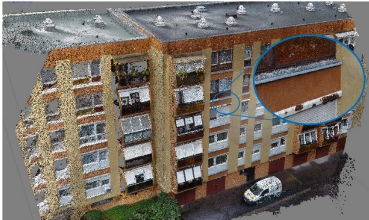
18. ábra Panelépület homlokzati felmérése során fotókból generált pontfelhő állomány
