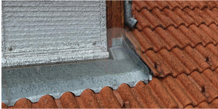
16. ábra A GPS információkat tartalmazó képek alapján előállított pontfelhő részlet a felmért sorháztól
