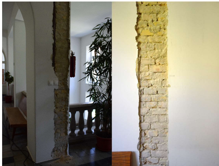
9. ábra: F1-08 jelű (emeleti) és F0-09 jelű (földszinti) falfeltárás (saját felvétel)
