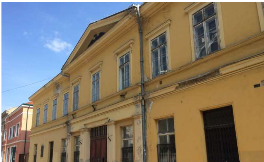
10. ábra: Fekete Sas Szálló domináns homlokzata (saját felvétel)
