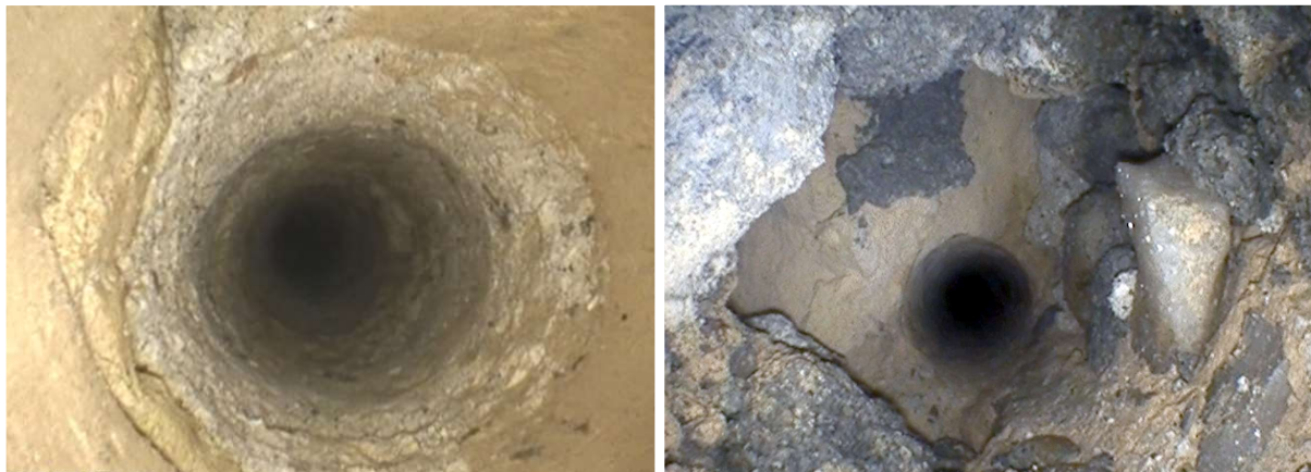
63. ábra: Video endoszkóp vizsgálat rögzített felvétele homogén szerkezet (bal oldalon, saját felvétel) és üreges szerkezeti kép (jobb oldalon, saját felvétel)
