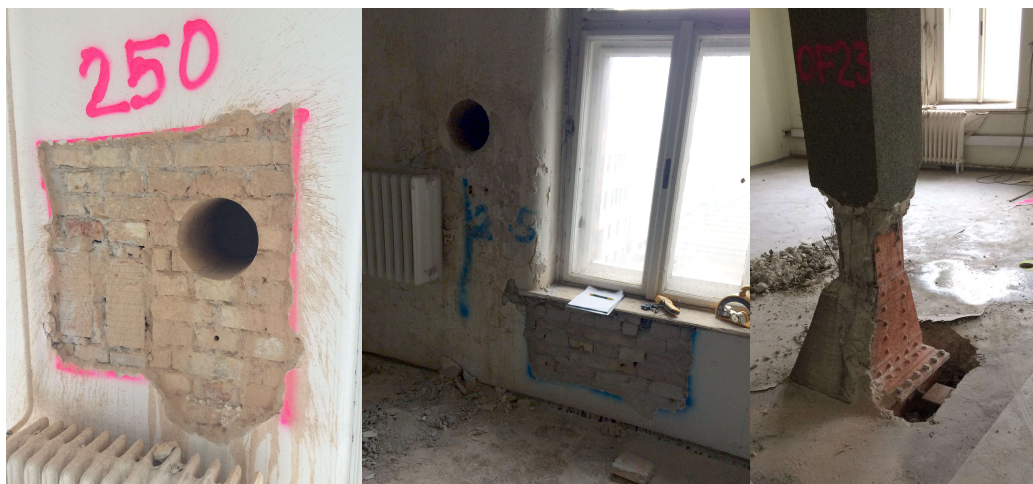
13. ábra: Budapesti többszintes kereskedelmi épület feltárási és mintavételi helyek (saját felvételek)
