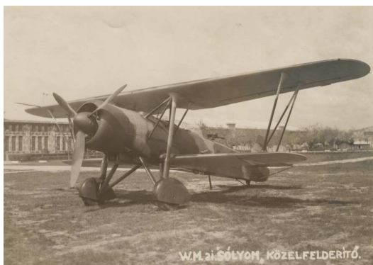
18. kép: WM 21 Solyom közelfelderítő gép, az egyetlen magyar tervezésű, sorozatban gyártott harci repülőgép, mely alkalmazásra került a háborúban (a szerző gyűjteményéből).
