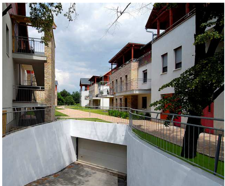
A lakópark garázs bejárata
