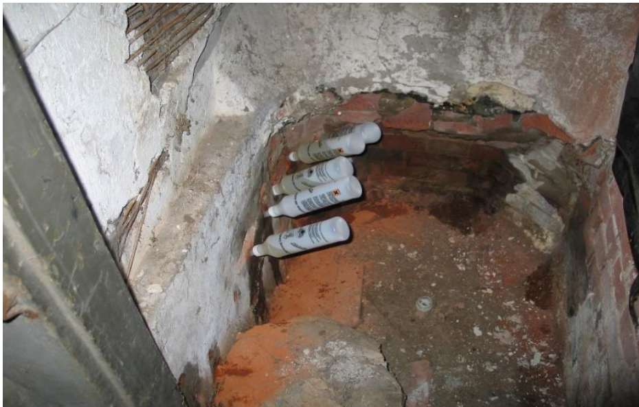
Bild 8: Drucklose Applikation von IM an Mauerwerk. Die Kartuschen sind in ein geneigtes Bohrloch eingebracht; durch die Neigung der Kartusche erfolgt ein kontinuierlicher Nachlauf von IM in das Bohrloch (Quelle: Dahlberg-Institut Wismar)
