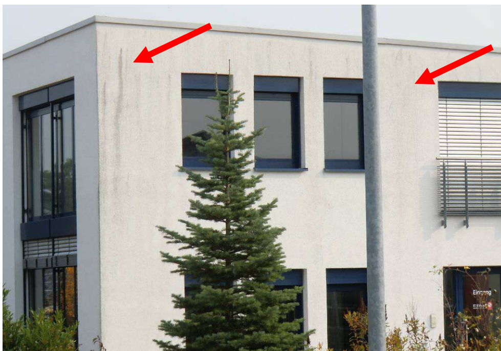
Abb. 05: Büro und Verwaltungsgebäude in der Eifel (Deutschland).
