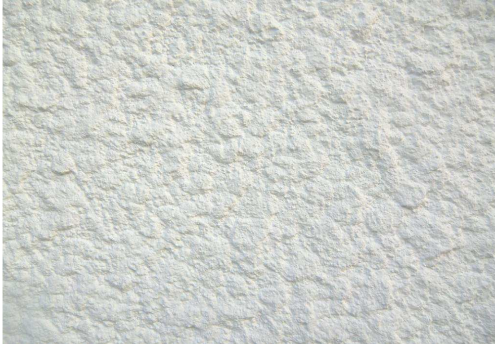
Abb. 22: Wohnhaus in der Eifel (Spritzputz).
