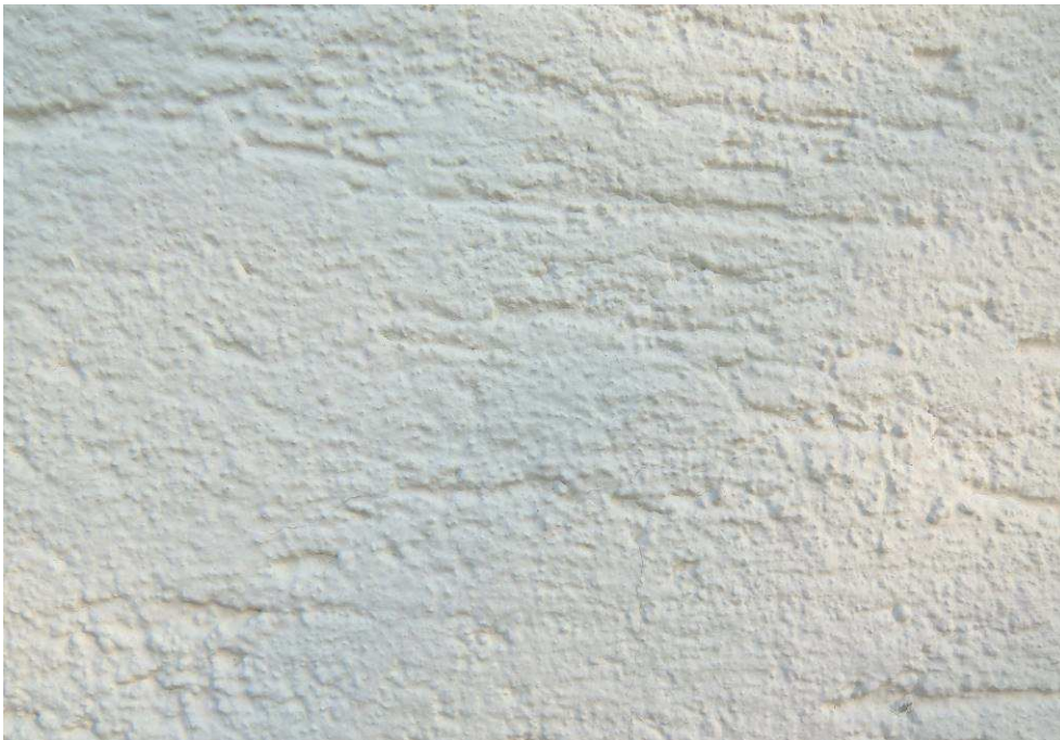
Abb. 25: Wohnhaus in der Eifel (Rillenputz).
