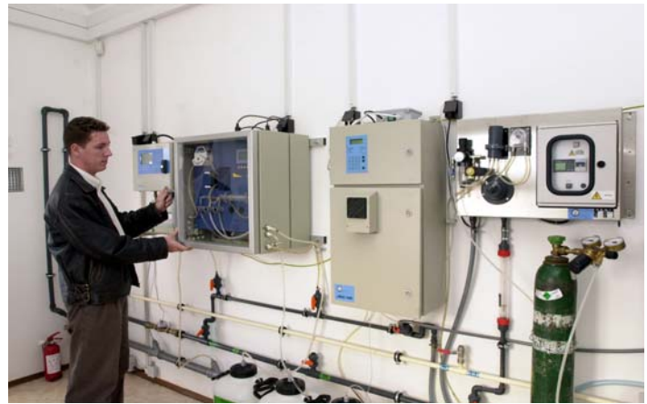
4.1. ábra: A Dráva Automata Monitor Állomás Barcson a.; Vízkivételi mű b.; Műszerpark (Forrás: KOVÁCS A. 2002A; DOLGOSNÉ KOVÁCS A. 2003)
