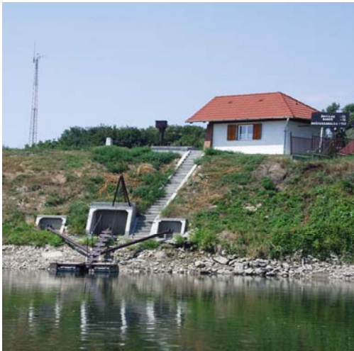
4.1. ábra: A Dráva Automata Monitor Állomás Barcson a.; Vízkivételi mű b.; Műszerpark (Forrás: KOVÁCS A. 2002A; DOLGOSNÉ KOVÁCS A. 2003)
