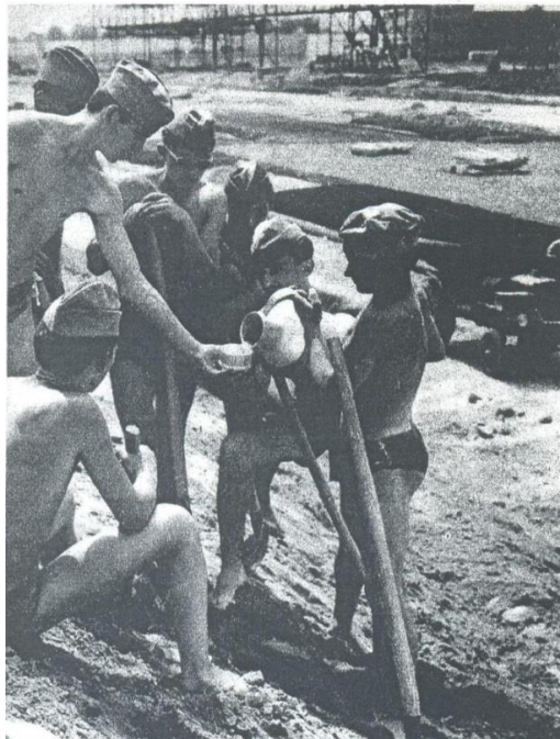
KISZ-fiatalok önkéntes munkabrigádja a Dunai Cement- és Mészmű építkezésénél
