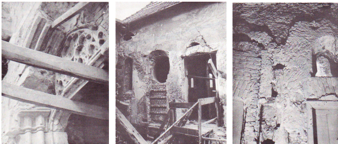
25-27. A zsinagógatér vakmértműves kibontott kapuja, a keleti homlokzat és az emeleti ablakok kutatás közben
