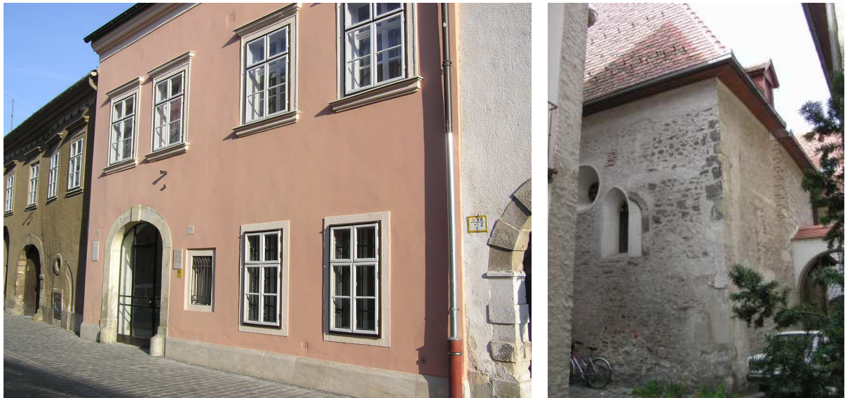
21-22. ábra. Az Új utca 11. számú épület utcai homlokzata és a zsinagóga tömege az átjáró felől
