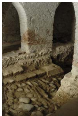
A pinceszint képe a feltöltés kihordása után Jól látható a középkori burkolatra épített pillérsor alapozása és a megmaradt császárfal alapköve, amely a törökkori fafödém mestergerendáját támaszthatta alá.
