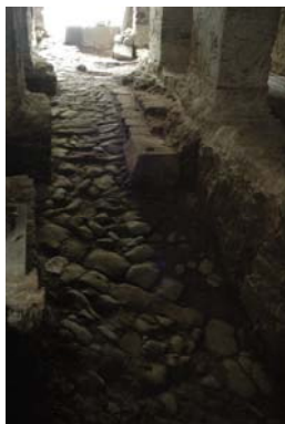
A pinceszint képe a feltöltés kihordása után Jól látható a középkori burkolatra épített pillérsor alapozása és a megmaradt császárfal alapköve, amely a törökkori fafödém mestergerendáját támaszthatta alá.
