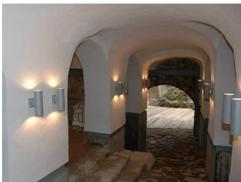
A pinceszint képe a feltöltés kihordása után Jól látható a középkori burkolatra épített pillérsor alapozása és a megmaradt császárfal alapköve, amely a törökkori fafödém mestergerendáját támaszthatta alá.
