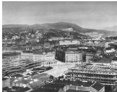
Budapest, az épülő Szabadság tér
