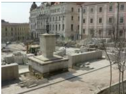
Burkolatépítés az örökmécsesnél
