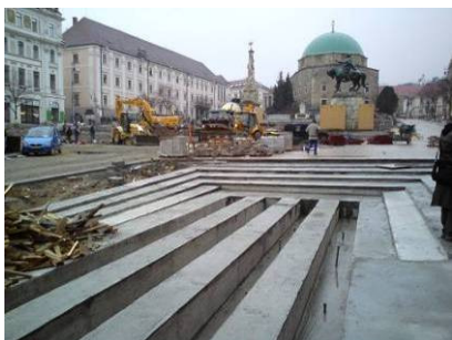
Vízjáték szerkezete a Városháza előtt
