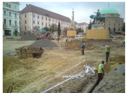
Közműépítés a keleti oldalon
