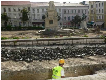
Közműépítés a nyugati oldalon
