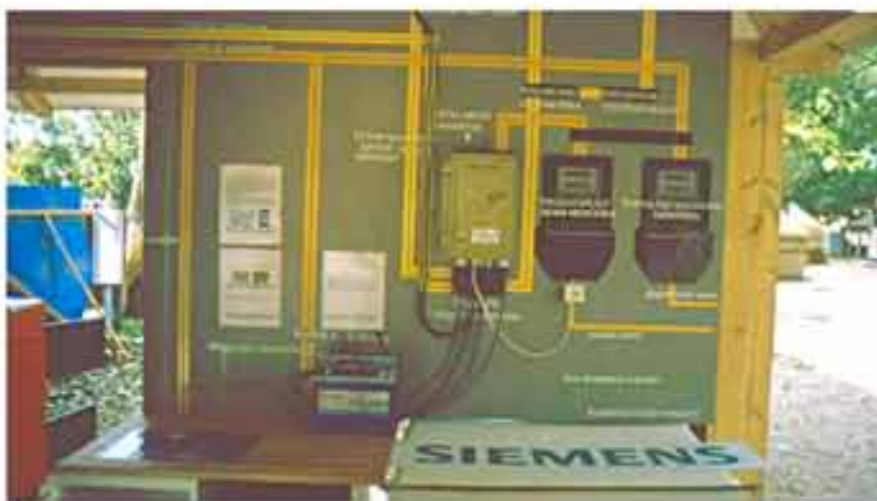
szél- és napenergiás, hálózattal kooperáló elektromos rendszer
