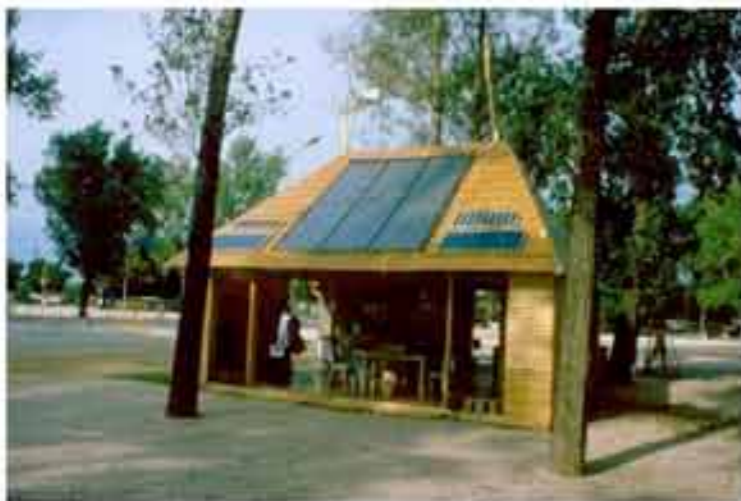
50 m2 alapterületű modellház könnyűszerkezet, természetes hőszigetelőanyagokkal és földtégla kitöltő falazattal, faszindely-fedéssel
