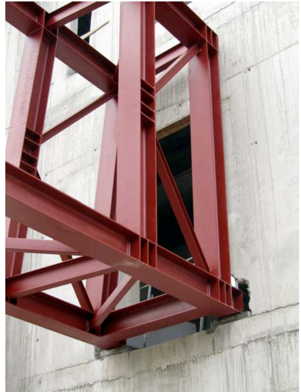
A kivitelezés állapota 2011 decemberében – A 'B' épület délkeleti sarka, valamint a 'B' és a 'C' épületek közötti híd felfekvése Fotó: Halász György
