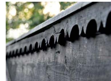
83. kerítés 2010 Siklód (RO)
