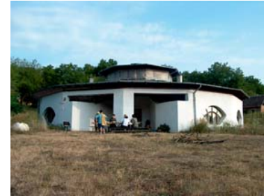
91. a „Zsilip” (befogadóház)
