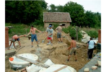
92. földház szerkezeti feltárása
