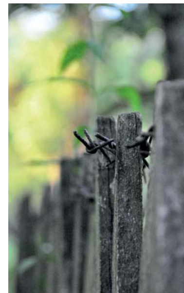
66. kerítés 2010 Siklód (RO)
