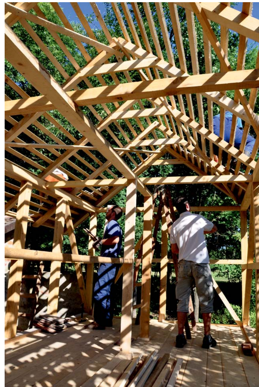
02. góré építése 2013 Ópusztaszer
