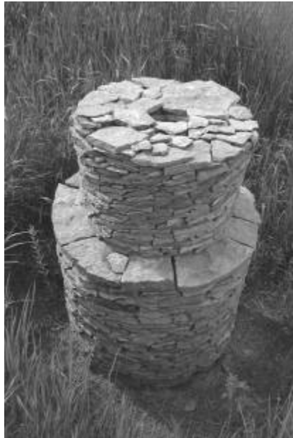
62. ábra: Kéménykürtő, 2004, dacit-andezit tufa szárazon rakva (80 x 130 cm) (fotó: B. P.)
