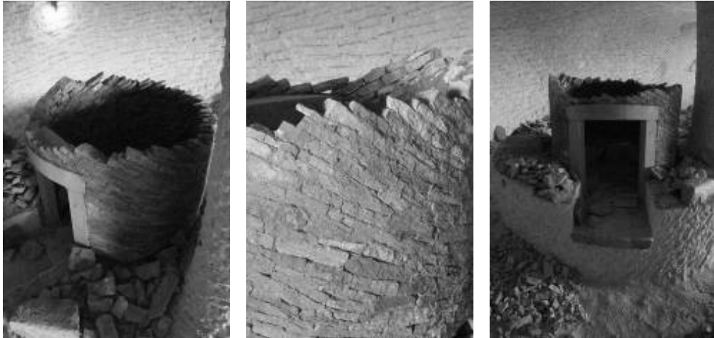
54. ábra: A kövek spirális építése önhordó szerkezetet eredményez
