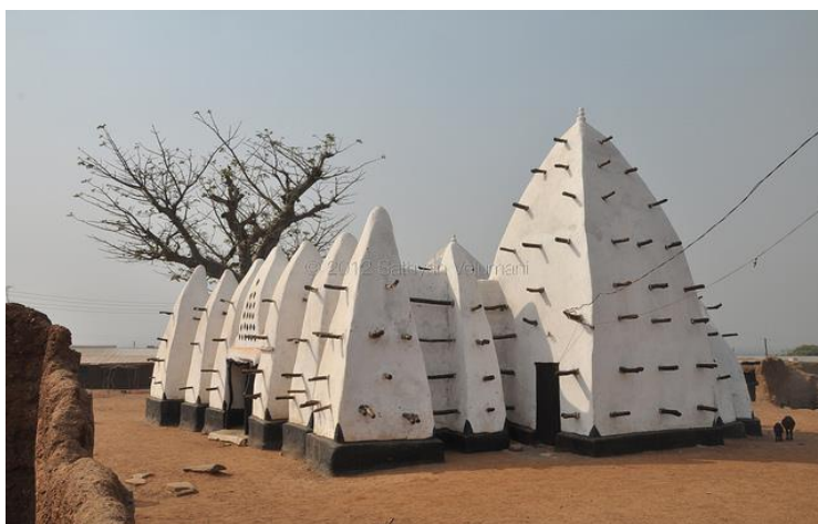
1. ábra Ghana agyagból és fa cölöpből álló vályogháza
