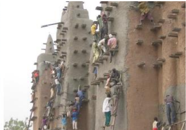
6. ábra A facölöpök állandó állványzatként szolgálnak
